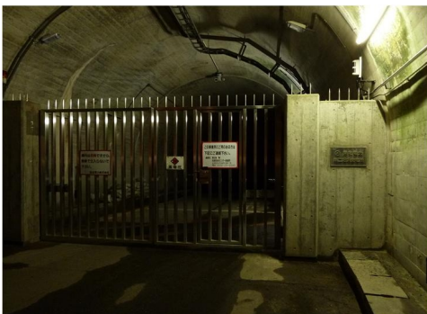
第二沼沢発電所
